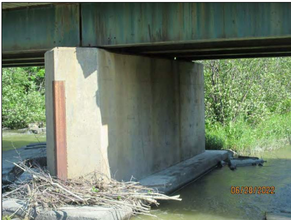
Pier Nosing (Debris)
