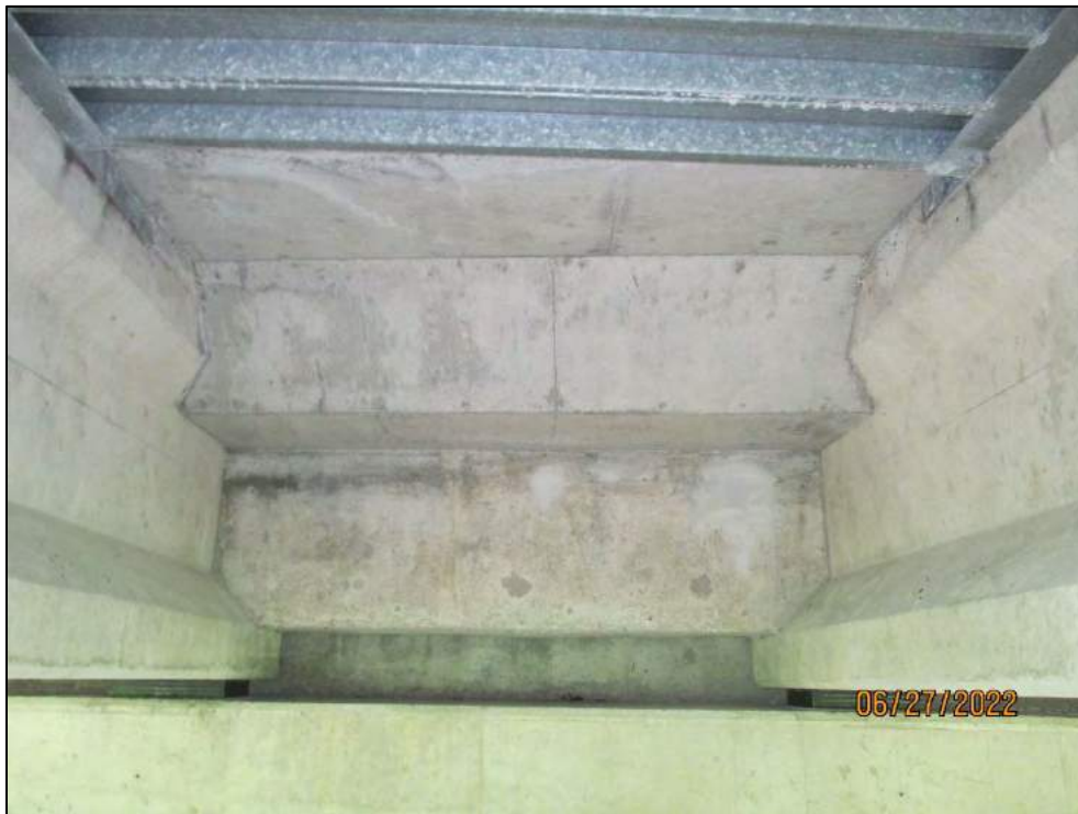
Deck End Diaphragm (Typ.)
