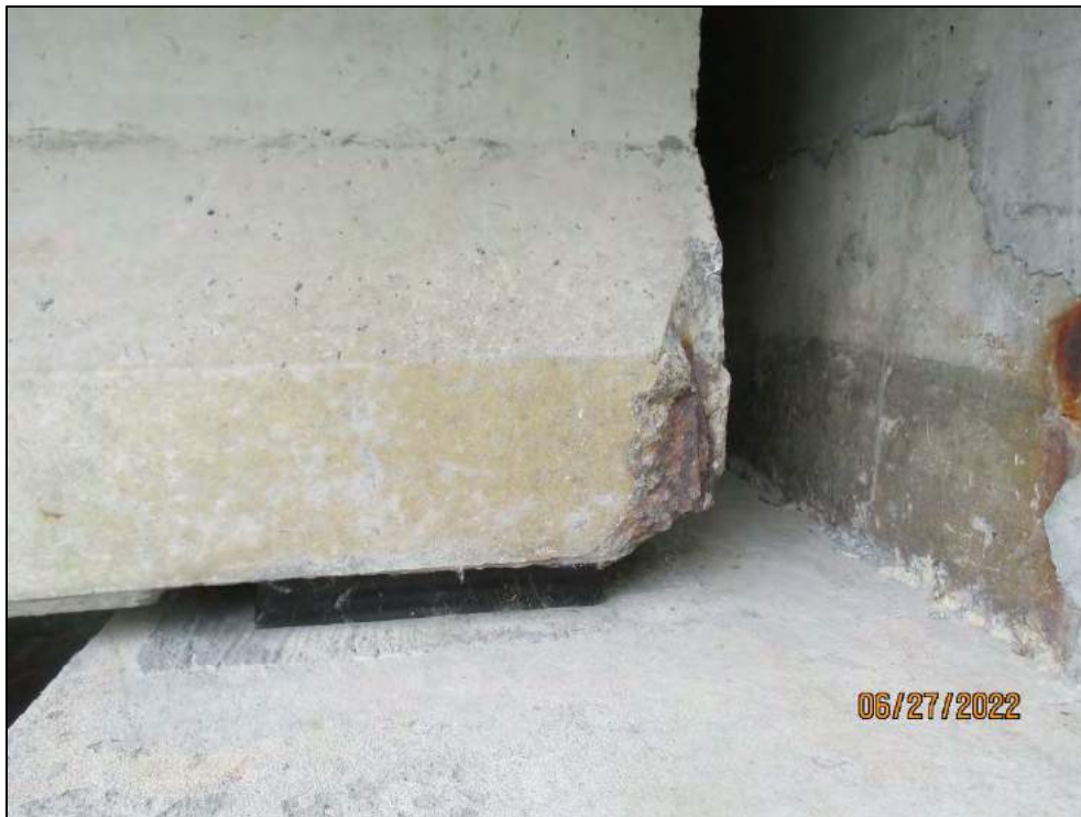
Girder End Spall – S/E
