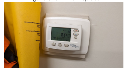
Figure 35: Thermostat controlling F1
